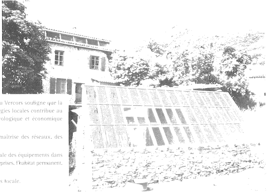
Panneaux photovoltaïques de la ferme de Vincent Hutter (Photo : Parc Vercors)
