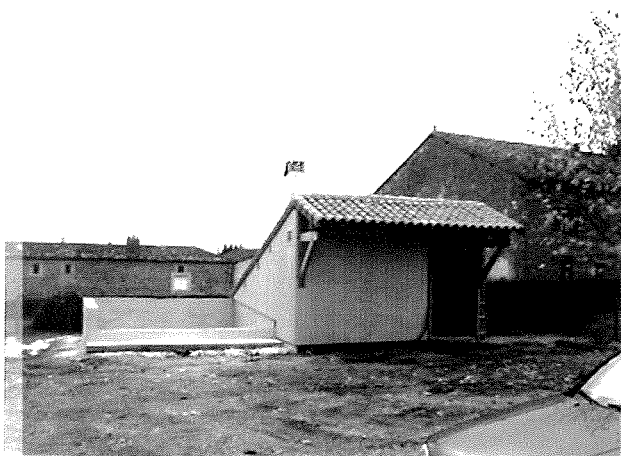
Chaufferie du Bourdeix : silo de stockage des plaquettes et local de la chaufferie
