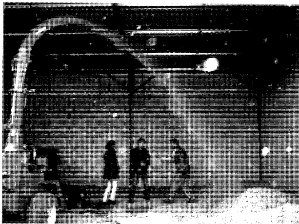
Chaufferie du Bourdeix : local de la chaufferie
