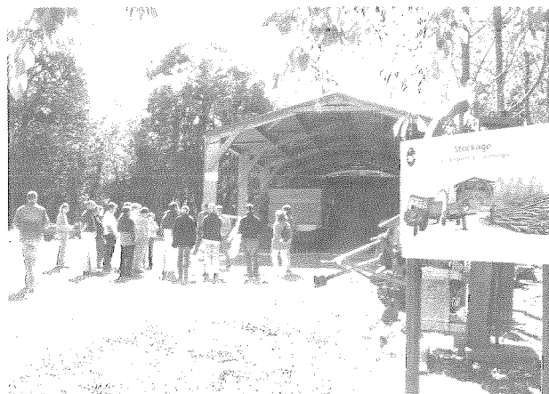
Hangar de stockage de la chaufferie bois de la maison du Parc du Morvan (photo : C. Biard)
